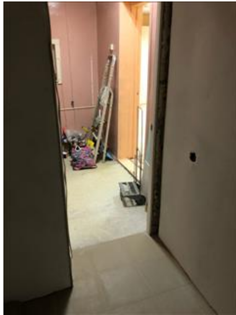
Кладовая в ремонте Создаем комнату мамы и ребенка
